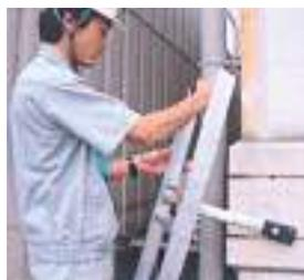
サンノテが壁面から離すので、パイプや配線を跨ぎ、作業を正面から行うことができるため、安全で作業効率も向上します。
